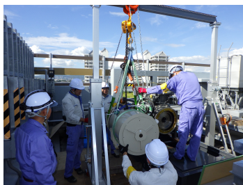
発電機分解搬入組立工事
