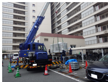
発電機更新工事
