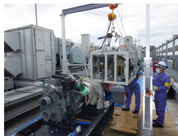
発電機分解搬入組立工事
