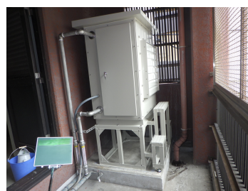
発電機ラジエーターユニット 制作更新工事
